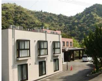
(本館から新館を望む)
