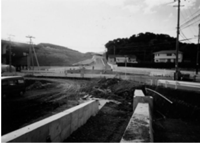
市道野口熊野線工事のようす
